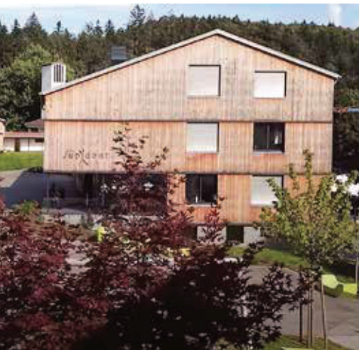
Das Jupidentgelände erstrahlt im neuen Glanz: Das sanierte Verwaltungsgebäude
